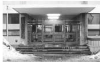
昭和37年 1号棟新築
