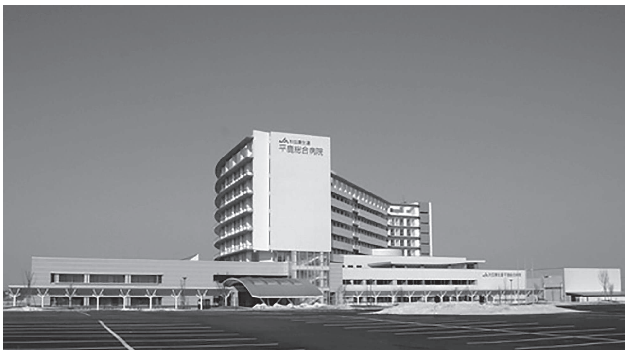
新病院（平成19年4月1日開院）
