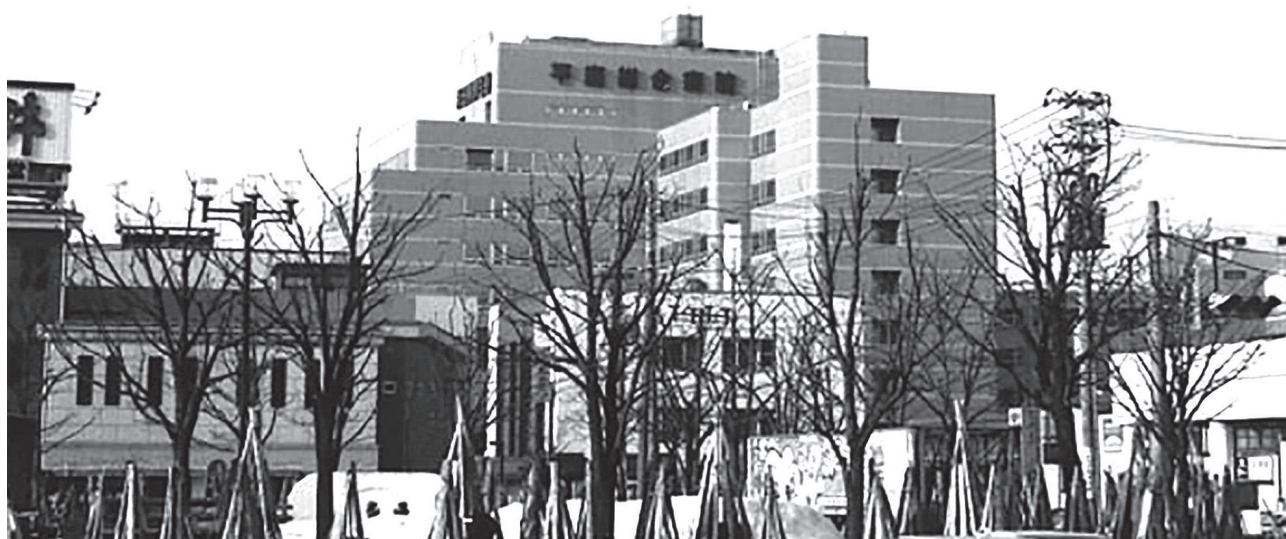
ピンク棟完成時（昭和62年3月20日落成）
